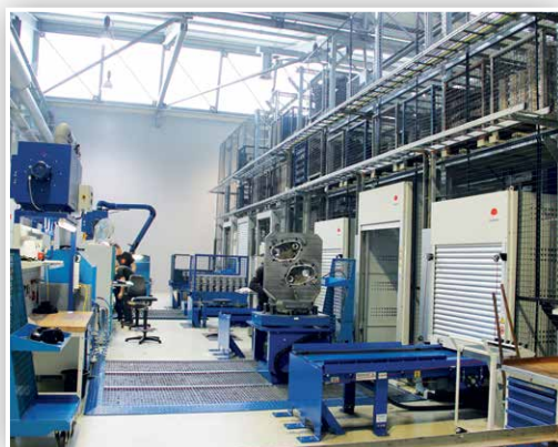
Zentralisierte Automation: Der knapp 50m lange Fastems Pallettenbahnhof bildet das Herzstück der modernen Produktion und versorgt 4 BAZ mit aufgespannten Rohteilen.
